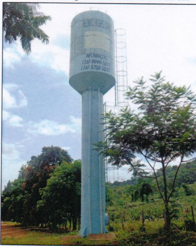
Foto 15 - Bairro Águas Claras - Reservatório elevado
