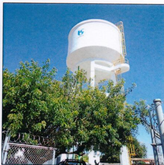
Foto 6 - Reservatório Elevado 01 (T01)
